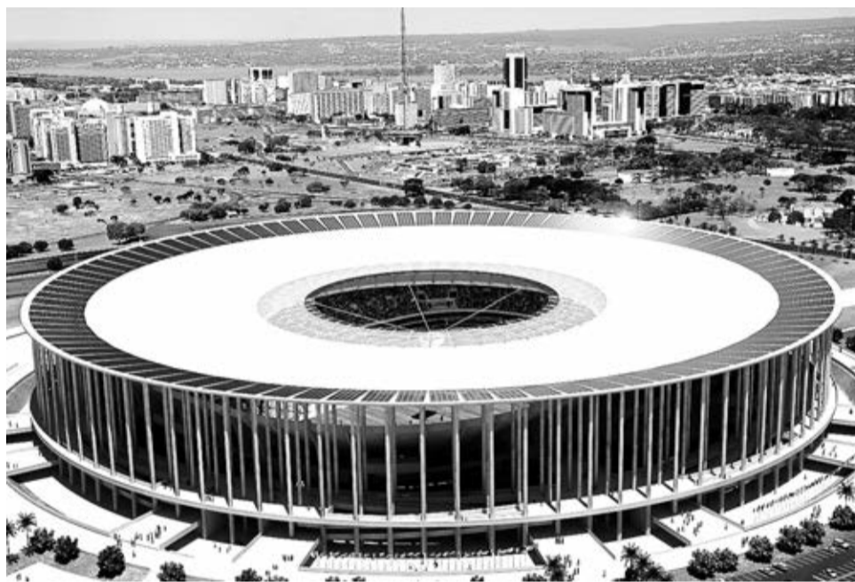
Membrana fotocatalítica que cobre o tecto e neutraliza a poluição atmosférica
